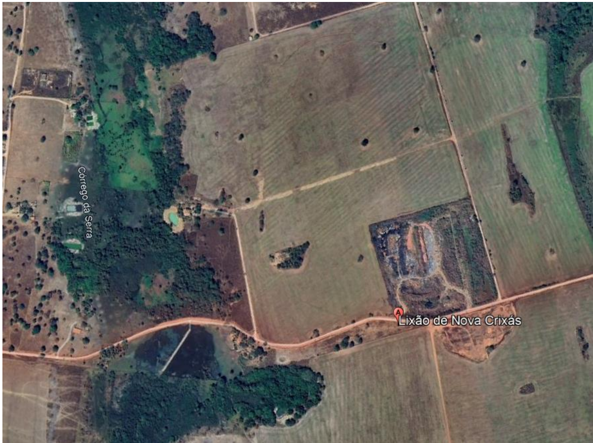
Figura 3.78: Vista aérea do lixão de Nova Crixás. Fonte: Google Earth (2025).
